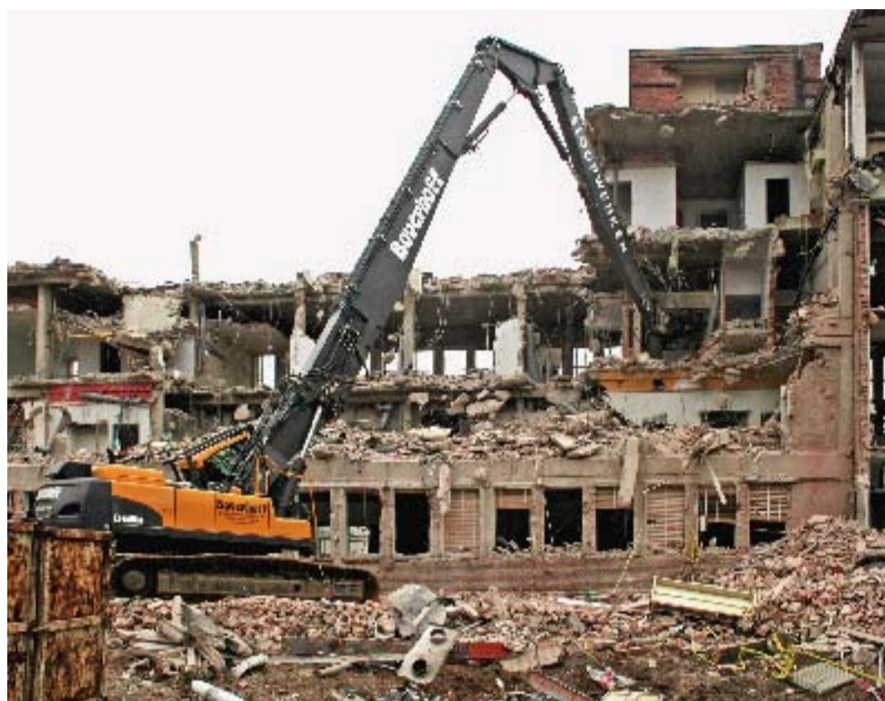
Foto 1: De Volvo EC460C en de Hitachi 470LCH-3 bezig met werkzaamheden in de tweede lijn.
