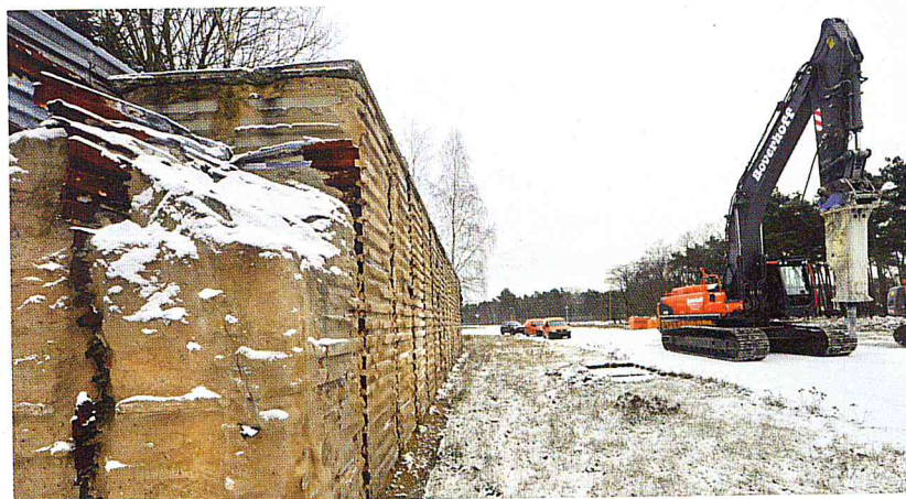
De Volvo EC460-C met 5,5 tons Furukawa sloophamer gaat op weg naar de volgende bunker.
