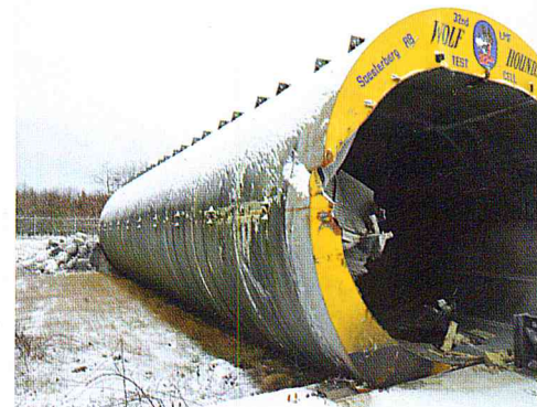
Een stalen bunker voor het opvangen en zuiveren van uitlaatgassen van de naverbranders van de vliegtuigen staat klaar om kapot geknipt te worden.
